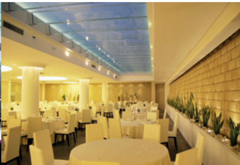
Solaio calpestabile composto da lastre e travi in vetro stratificato. Hotel Mec Paestum Capaccio-Paestum (SA). Progetto architettonico e realizzazione: Tecno Montaggi s.r.l. Strutture: ingegneri Gianfranco Marra, Nello De Sena, Giuseppe Casilli
