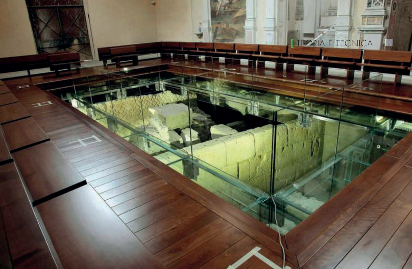
Pavimentazione a sbalzo mista in vetro ed acciaio. Chiesa Sant'Agnello a Caponapoli – Napoli. Progettista: architetto Ugo Carughi
