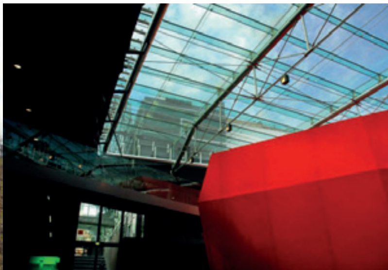
Copertura mista composta in lastre e travi in vetro stratificato ed acciaio. Museo MACRO – Roma. Progettista: architetto Odile Decq
