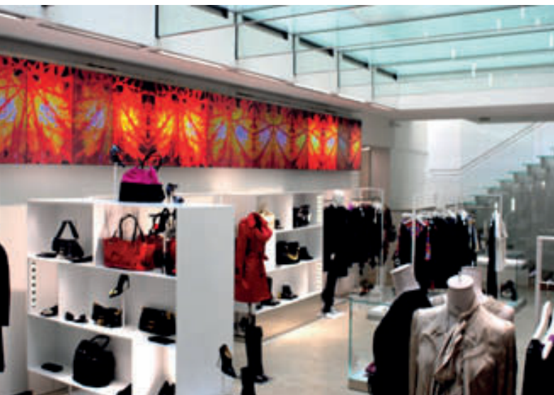
Solaio composto da lastre e travi in vetro stratificato. Negozio Luisaviaroma - Firenze
