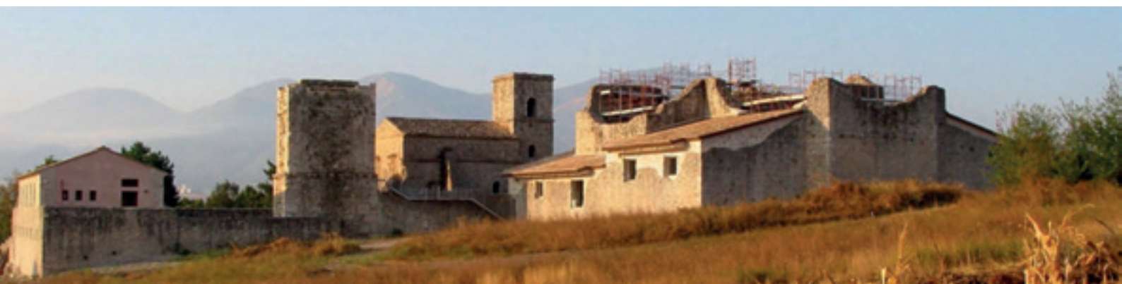
Restauro dell'Abbazia del Goletto, architetto Angelo Verderosa
