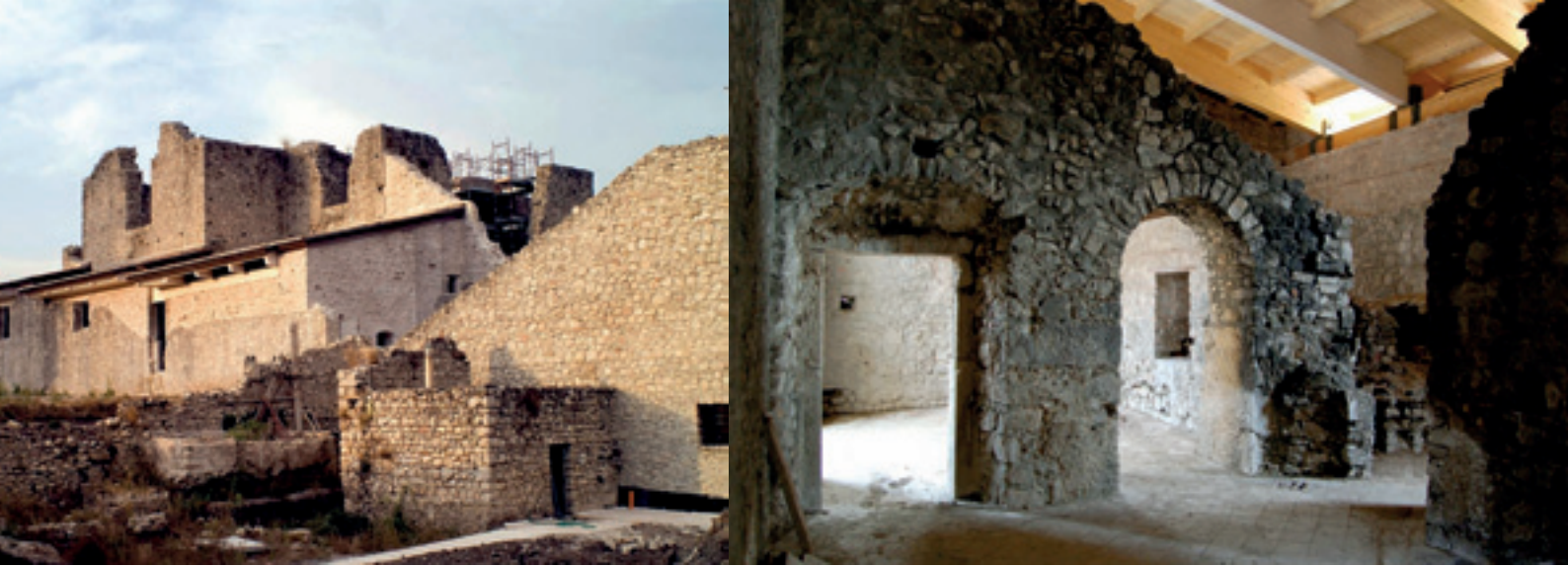
Restauro dell'Abbazia del Goletto, architetto Angelo Verderosa
